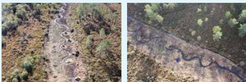
Travaux de remise en fond de vallée et de restauration du Moulinet dans la Tourbière. Crédit photo : R. CRIOU - COLAS 2022
