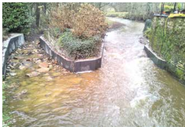
Effacement du seuil du moulin du Gué et création d'une rampe d'enrochement à Plélan le Grand
