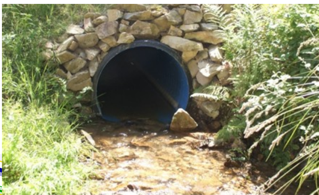
Petit ouvrage remplacé par une buse
