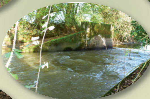
Moulin des Epinais : Suppression du clapet
