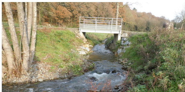
Aménagement de l'ouvrage et installation d'une passerelle (Ploërmel-56)
