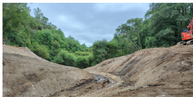
Effacement d'une digue (Saint Jean-Brévelay-56)
