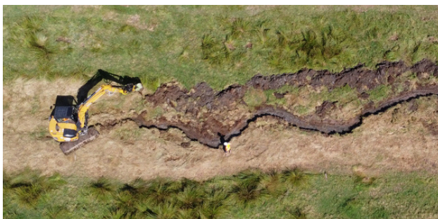
Remise du cours d'eau dans son talweg d'origine (Colpo-56)
