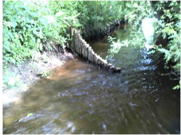
Risbermes et épis mis en place sur un cours d'eau du bassin versant du Trévelo – Source : Hardy Environnement
