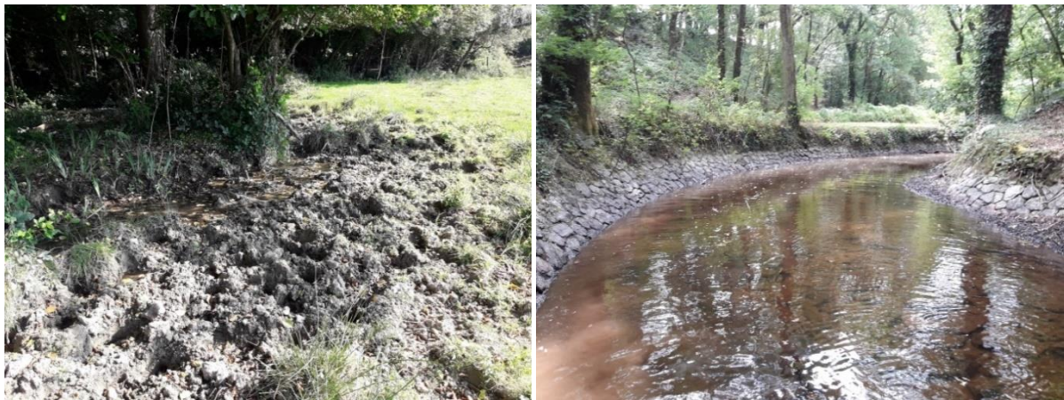
Figure 96 : situations dégradées - Source : HARDY ENVIRONNEMENT
