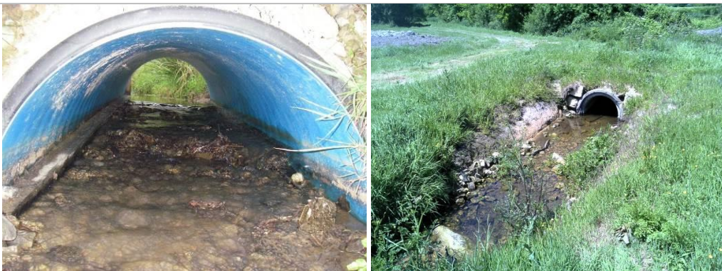
Remplacement ou recalage d'une buse - Source : Syndicat Intercommunal du Haut Couesnon (35) ; Fédération de pêche 56 – Ruisseau du Trévelot (56)
