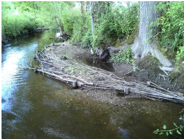
Risbermes et épis mis en place sur un cours d'eau du bassin versant du Trévelo – Source : Hardy Environnement
