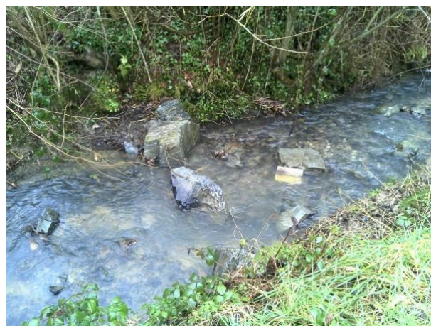
Pose de blocs dans un cours d'eau du bassin versant du Haut Couesnon – Source : Hardy Environnement
