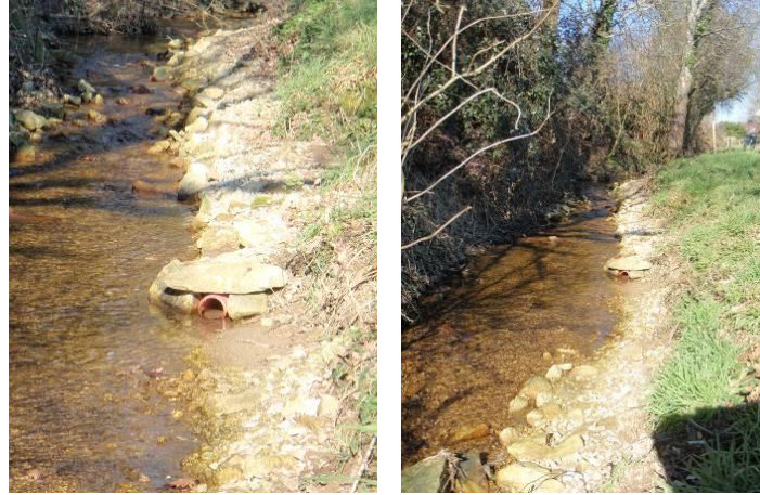
Allongement d'un drain en complément d'une opération de rehaussement du lit – Source Hardy Environnement
