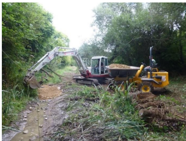
Recharge granulométrique de cours d'eau – Source : CAP Atlantique
