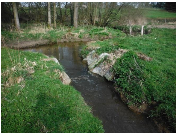
Ouvrage de répartition avec remise en fond de vallée partielle du cours d'eau – Source : Hardy Environnement Source : DIG Semnon 2021-2026
