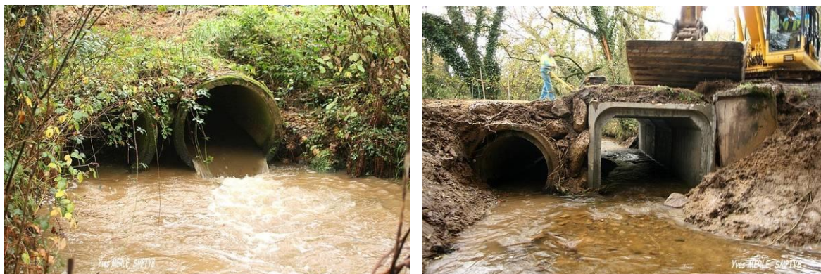
Remplacement d'une buse par un pont-cadre - Source : Pays d'accueil de la vallée du Blavet (56)
