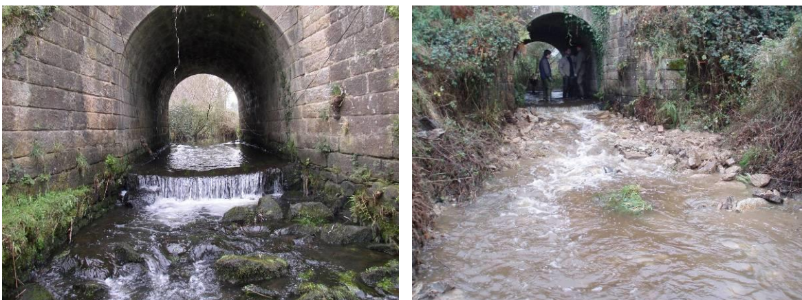
Aménagement d'une rampe d'enrochement -ruisseau du Trévelo (56) – Source FDPPMA 56
