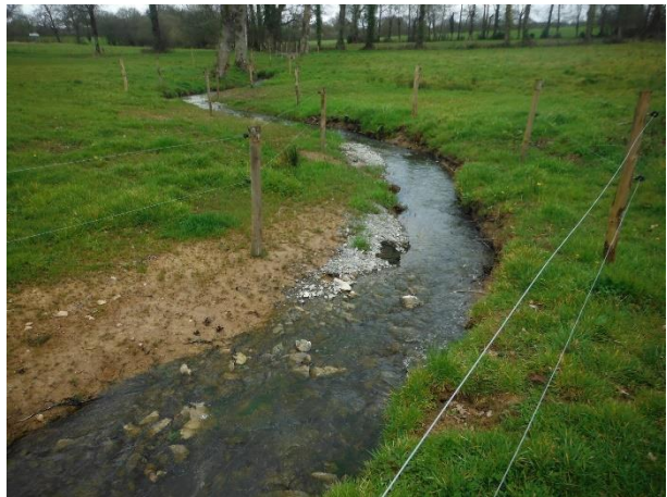
Remise d'un cours d'eau dans son talweg sur le bassin versant du Couesnon aval – Source : Hardy Environnement
