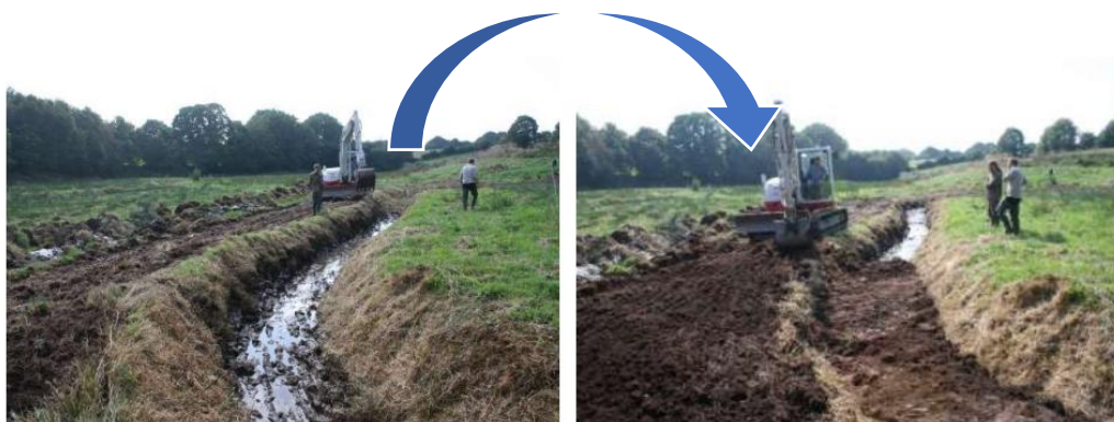
Exemple comblement total de fossé drainant par décapage des berges (source : Forum des Marais Atlantiques)
