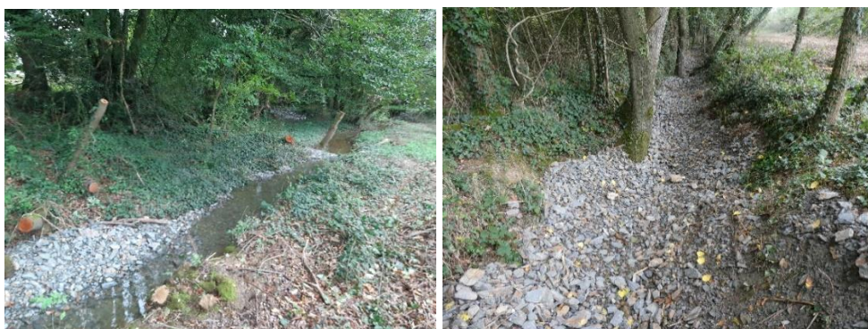
Exemple de rehaussement de lit par recharge granulométrique - Source : SMGBO Bassin versant du Ninian
