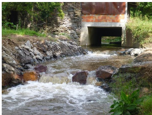
Exemple de seuils successifs - SMGBO bassin versant de l'Aff (56)
