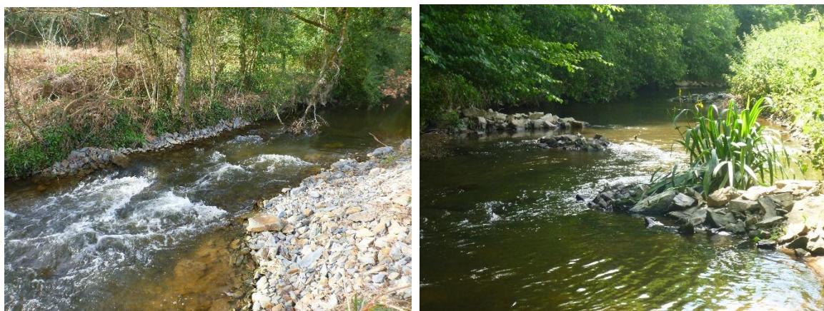
Exemple de diversification des habitats par banquettes et radiers - Source : SMGBO – Bassin versant du Ninian
