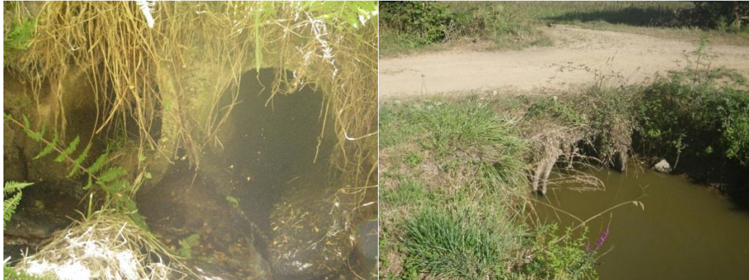
Ouvrage de franchissement d'une petite route à Sérent
