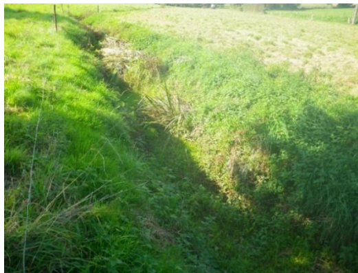
Lit mineur en situation dégradée à Sérén
