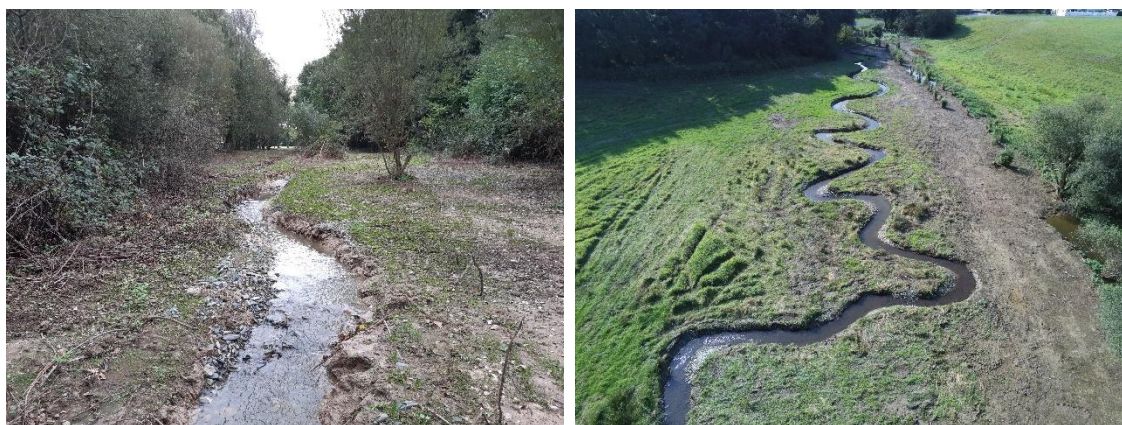
Exemple de remise en talweg - Source : SMGBO Bassin versant du Ninian
