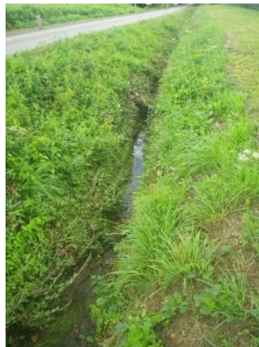
Lit avec débit en situation pas ou peu dégradée à Malestroit
