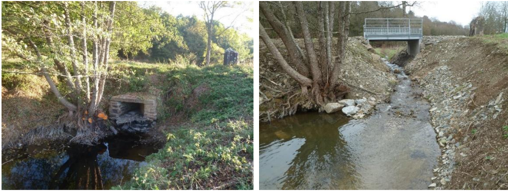
Exemple de remplacement d'ouvrage - SMGBO bassin versant du Ninian (56)
