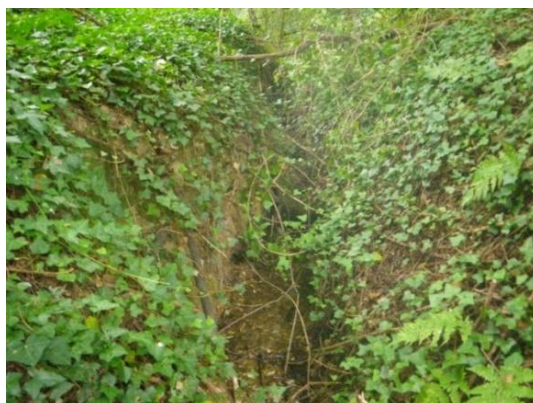
Berges et ripisylve en situation dégradée à St-Marcel
