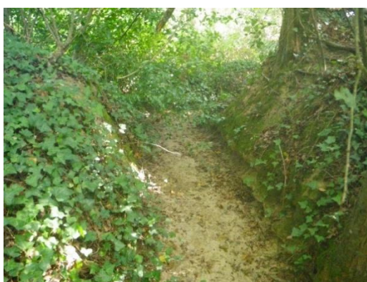
Lit mineur en situation dégradée à St-Marcel
