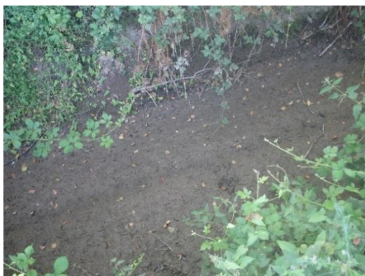
Lit mineur en situation dégradée à St-Marcel
