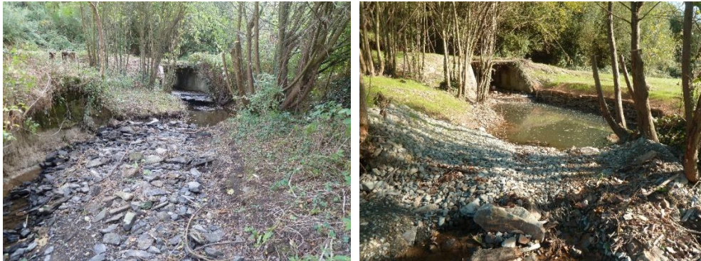
Exemple aménagement d'un ouvrage Ruisseau du Cö-Malville (56) (avant et après aménagement d'une rampe) - Source SMGBO
