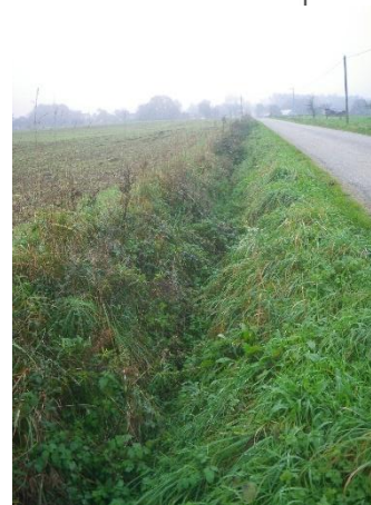
→ Tronçon Z3 Cours d'eau actuel = fossé de route perché
