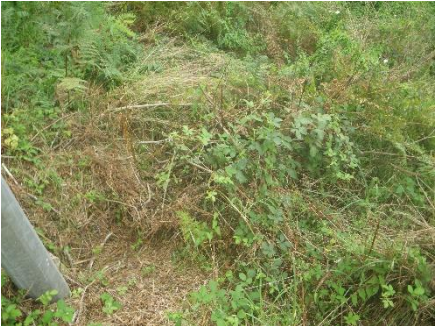
Buse CHATO_OUV_157 obstruée (Z6) :
