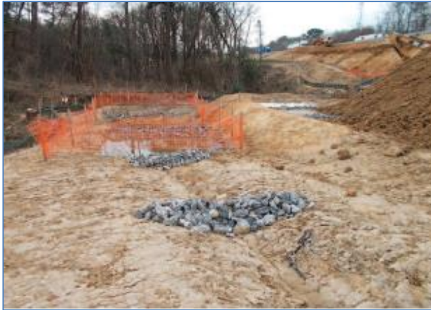
Exemple de mise en place de seuils en série (©Vinci)
