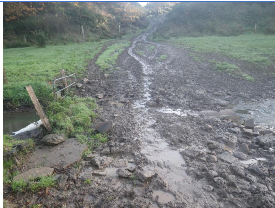
Passage busé, GARDSIT001
