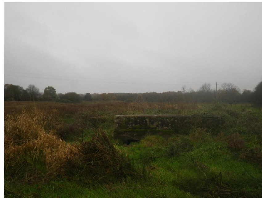
Vestige de l'ancien pont
