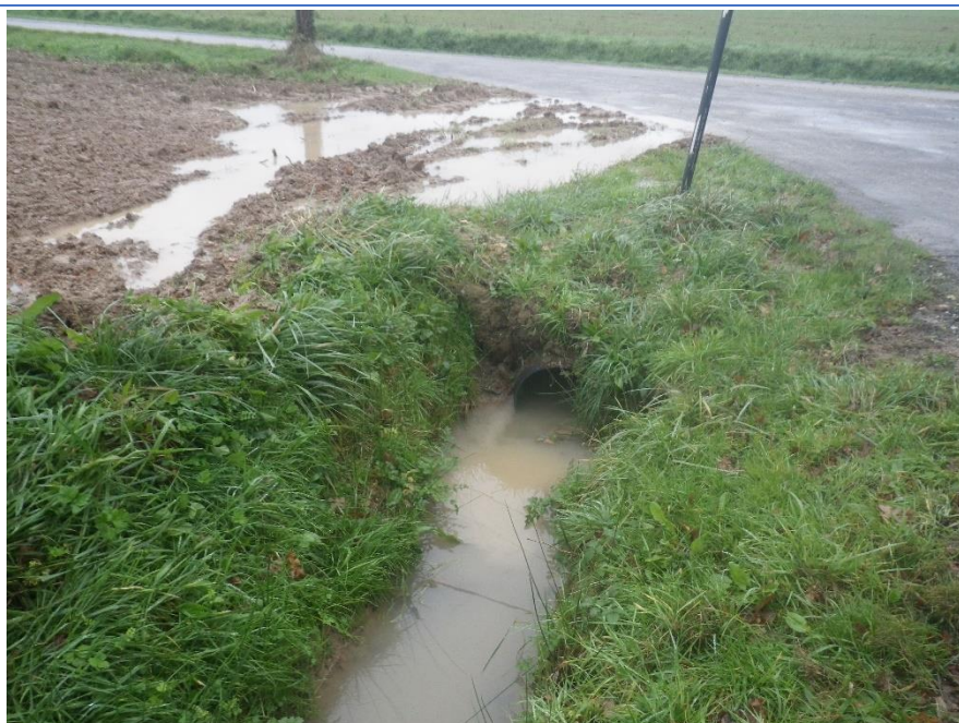
Intervention sur rigole et fossé, ACT_P_17
