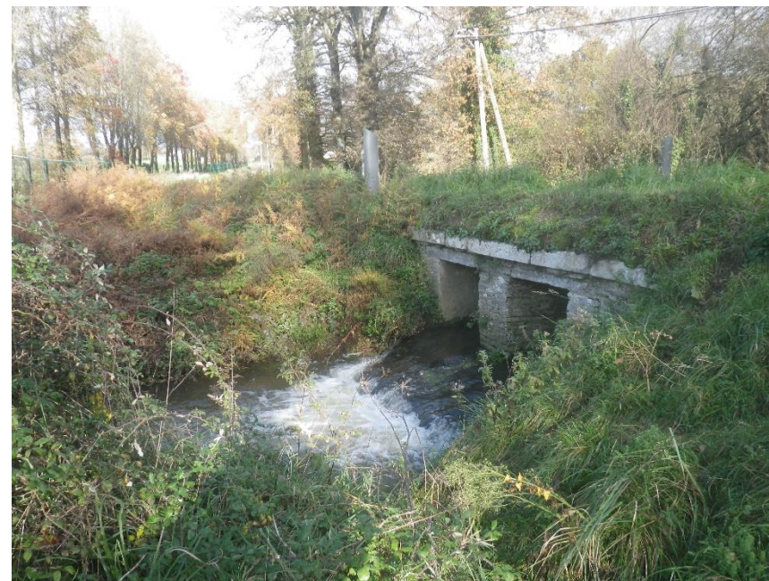
Rampe en enrochement : GUIDOUV001
