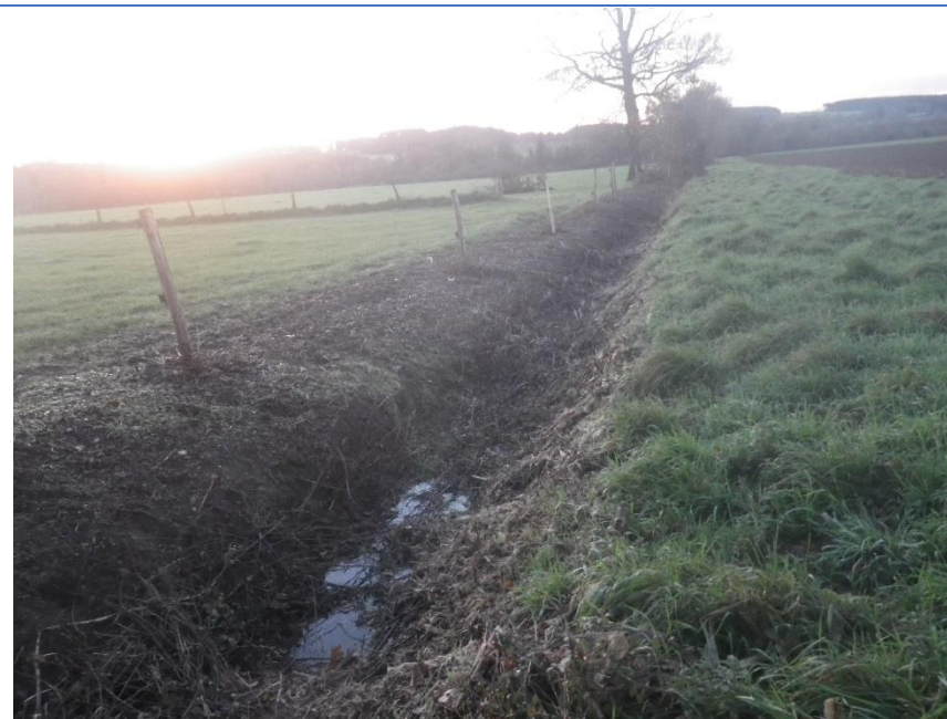
Remise en fond de vallée, en rive droite, PRIESEG002
