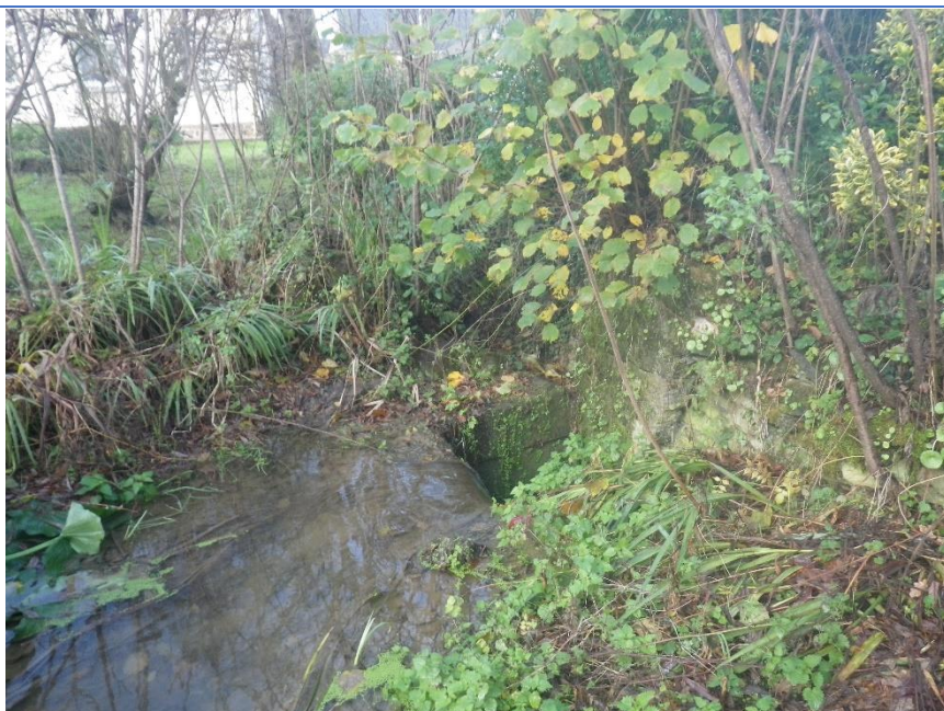
Suppression d'un ancien vannage, FONTSIT002
