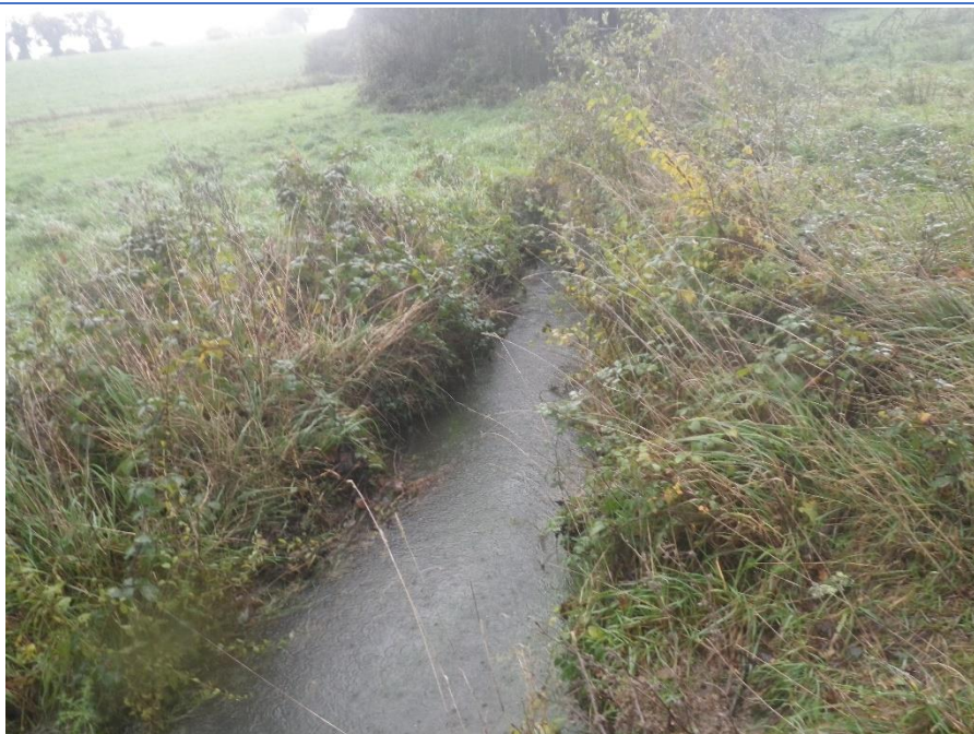
Rechargement de solide en tâche, BBRESEG002
