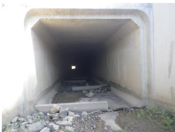
Exemple de mise en place de pont cadre
