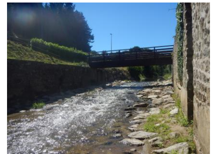
Exemple de rampe en enrochement
