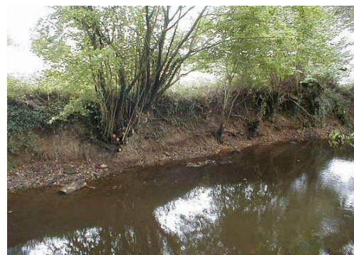
Figure : Exemple de travaux d'élagage
