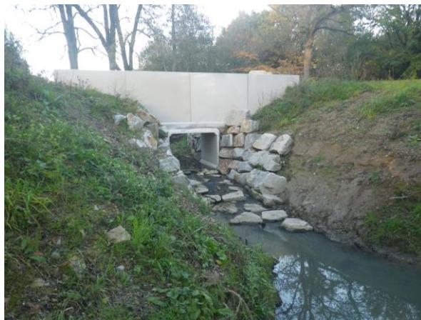
Exemple de mise en place de pont cadre
