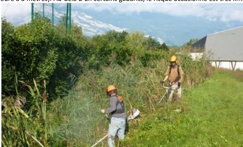
Figure : Chantier de débroussaillage sélectif
