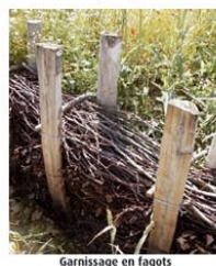
Mise en place de fascine (action complémentaire) (Source : Chambre Agriculture Eure 2008)
